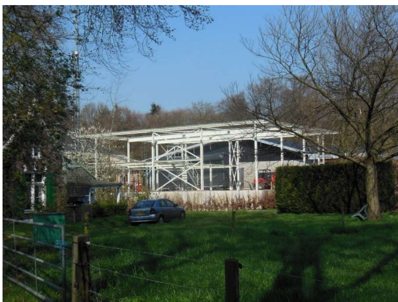
De overkapping in aanbouw, met links het gemeentelijke monument (tuinhuisje)
